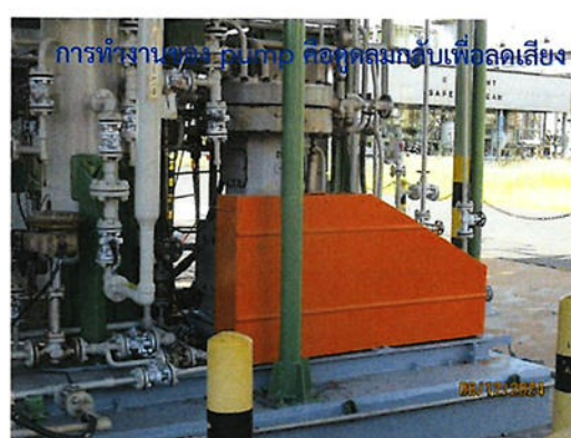
ภาพที่ 2-10 อุปกรณ์ครอบเครื่องจักรเพื่อลดเสียง
